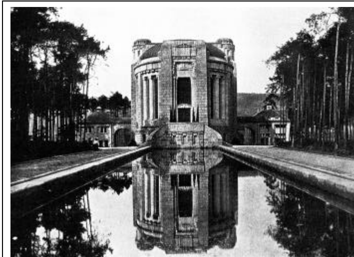
Figura 2 - F. Schumacher, Crematorio di Dresda, 1908-12, veduta generale prima dell'interramento della vasca d'acqua
