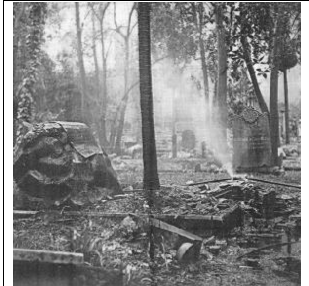
Figura 2 - Il cimitero prima dei lavori di sistemazione (1979 circa)
