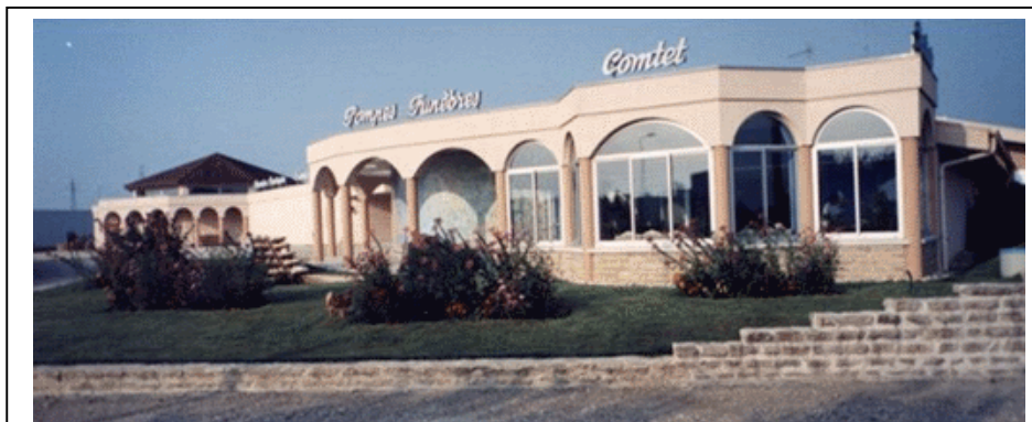
Figura 2 – Casa funeraria in Francia: la struttura di lieve entità architettonica ben si integra e s'armonizza nel paesaggio urbano.
