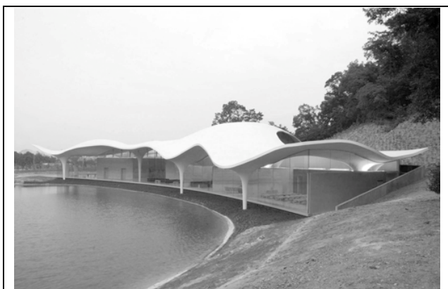
Figura 2 – Toyo Ito & Associati, crematorio “Meiso no Mori”, Kakamigahara, Gifu, Giappone 2004-2006, veduta d’insieme del padiglione che racchiude le strutture per i servizi funebri; da un lato si addossa alla collina come per esserne il prolungamento, dall’altro si specchia nel lago prospiciente
