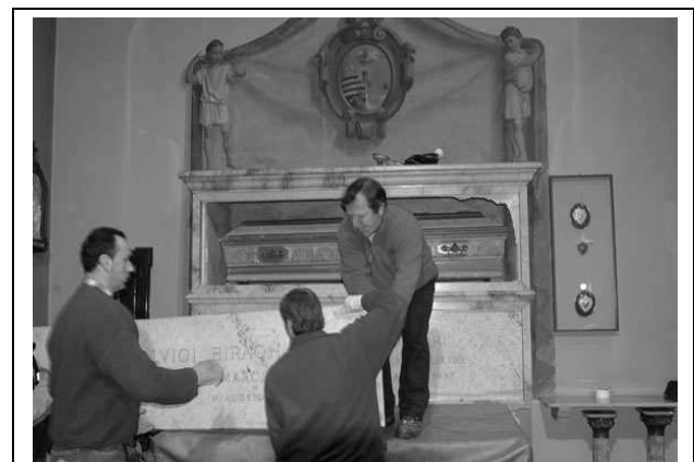
Figura 2 – Si procede al tamponamento dell’avello mortuario con lastra in pietra naturale ex art. 76, comma 9 D.P.R. 285/90
