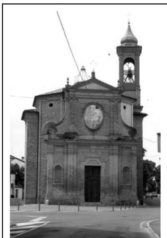
Figura 2 – Facciata del Sacrario
