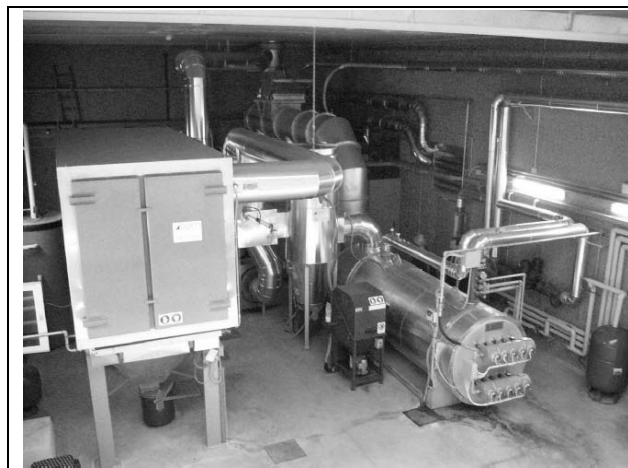
Figura 2 – Vista della zona tecnologica del crematorio di Bergamo con sezione di depurazione dei fumi
