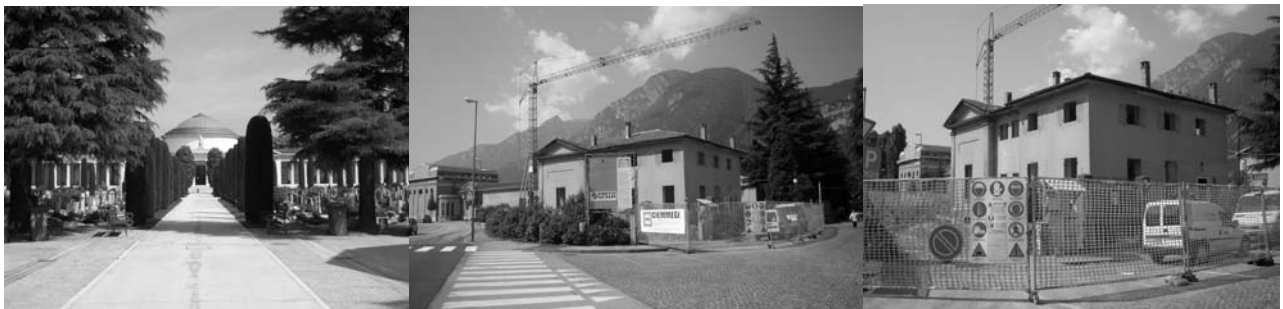
Alcune immagini del cimitero e dello stabile, in corso di ristrutturazione, situato all'ingresso dello stesso e destinato ad essere la futura sede dei Servizi Funerari del Comune di Trento
