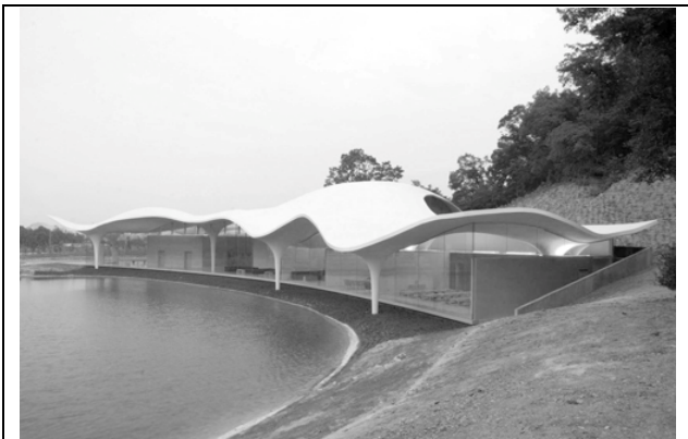
Figura 2 – Toyo Ito & Associati, crematorio “Meiso no Mori”, Kakamigahara, Gifu, Giappone 2004-2006, veduta d’insieme del padiglione che racchiude le strutture per i servizi funebri; da un lato si addossa alla collina come per esserne il prolungamento, dall’altro si specchia nel lago prospiciente
